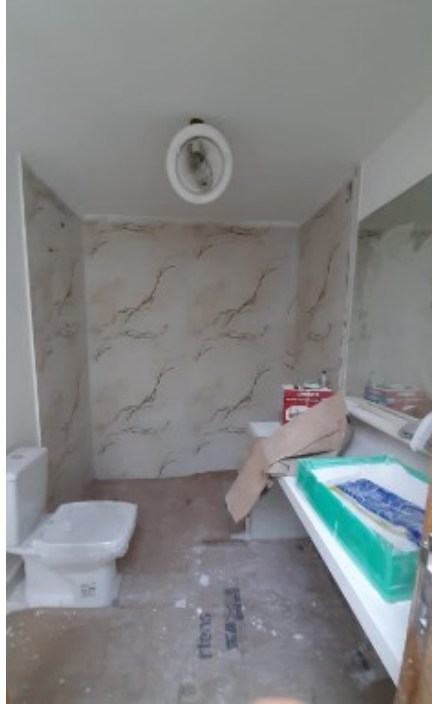
FOTO Nº 10 Vista parcial Banheiro da Suíte
