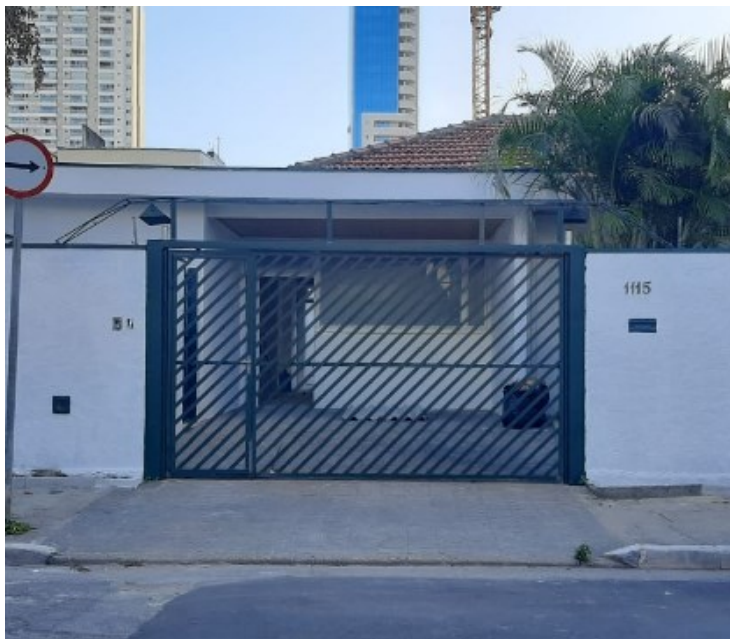
FOTO Nº 01 Vista parcial fachada da Casa
