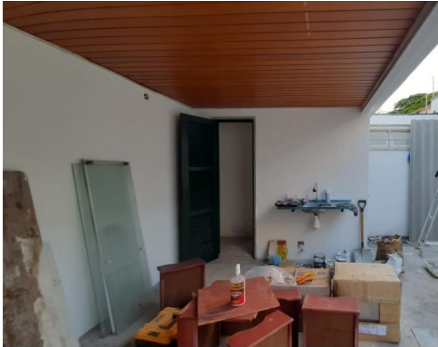
FOTO Nº 12 Vista parcial Quintal - Área coberta
