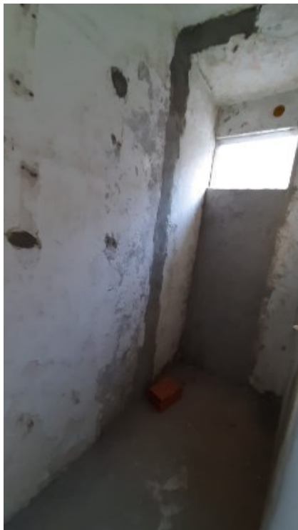
FOTO Nº 14 Vista parcial Banheiro dos fundos
