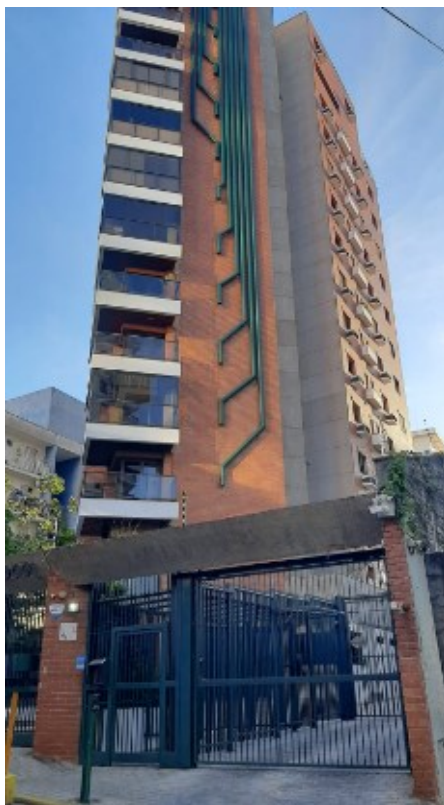
FOTO Nº 01 Vista parcial fachada do Edifício Dom Diogo
