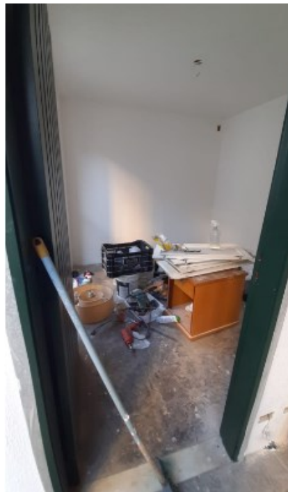
FOTO Nº 13 Vista parcial Quarto dos fundos
