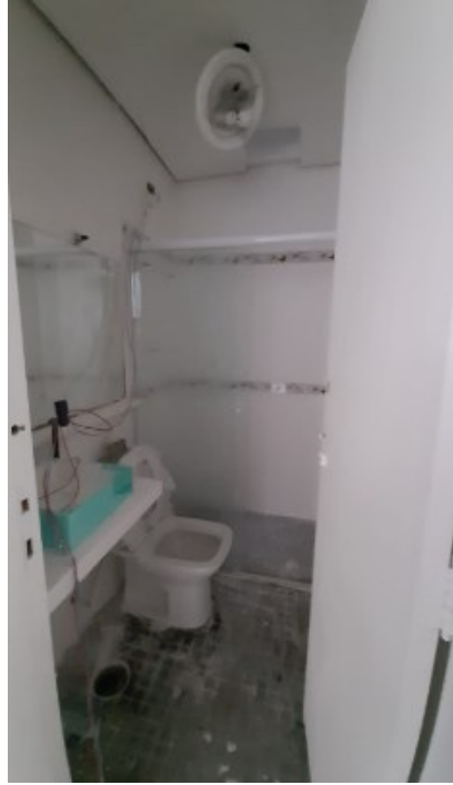
FOTO Nº 08 Vista parcial Banheiro Social
